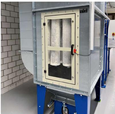
Filtereinheit für die Reinigung und Rückführung der staubhaltigen Luft
